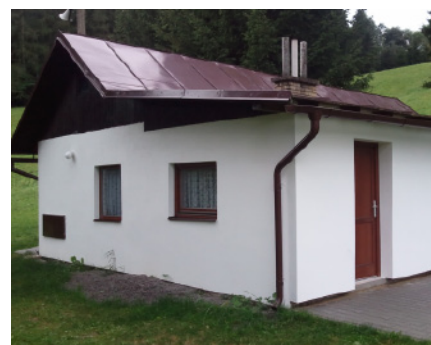
Tělovýchovná jednota Jablonné nad Orlicí Rekonstrukce objektu TJ – Malák Výše dotace: 146 322 Kč
