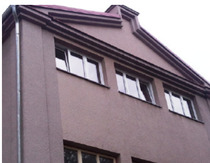
TJ Spartak Letohrad Výměna oken na sále kulturistiky, na schodišti a ve skladech objektu tělocvičny Výše dotace: 148 753 Kč
