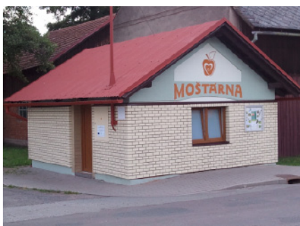
Základní organizace Českého zahrádkářského svazu Lukavice Renovace moštárny v obci Lukavice Výše dotace: 127 003 Kč
